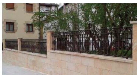
Nuevo muro de cierre de la parte trasera del Ayuntamiento (inversión contemplada en los Presupuestos de 2016).
