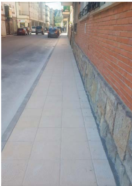
Ampliación y sustitución del pavimento de una de las dos aceras de C/Urbasa.
