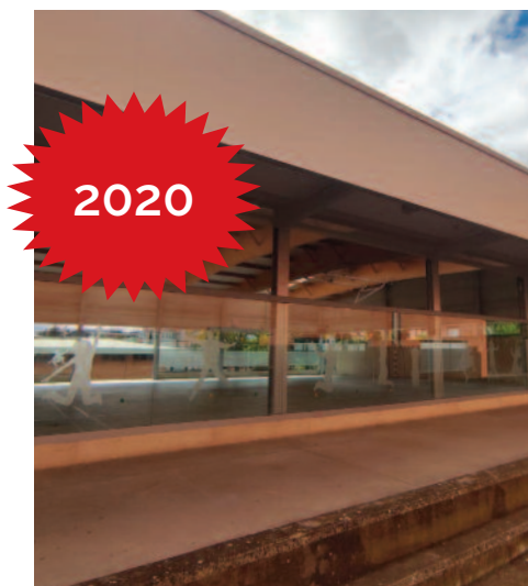
60.000 euros para cierre perimetral de la pista exterior de Lorenzo Goikoa.
